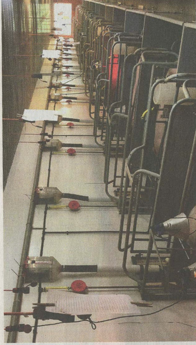
Bei diesen AquaLevel ist die Wasserleitung mit 1/2 Zoll zu klein dimensioniert; die Sauen saufen meist gleichzeitig, es kommt zu enormem Druckabfall; die Lösung: neue 1 Zoll-Leitungen.
