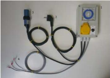
Die Stromversorgung der Schlauchpumpe erfolgt über die Steckdose der Schaltbox.
